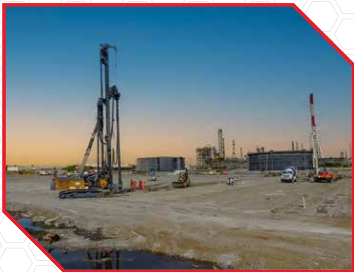
Ejecución de CMC en refinería.
