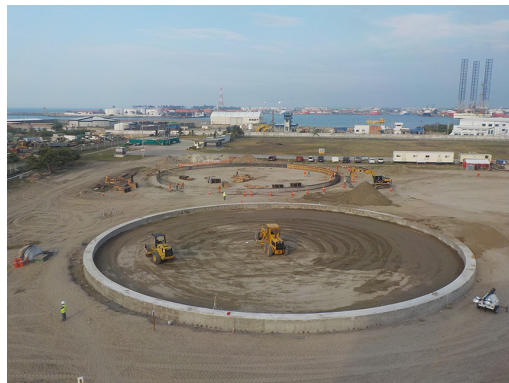
Ilustración 3: CIC instaladas en mallas regulares que densifican suelos arenosos y refuerzan los suelos que atraviesan.
