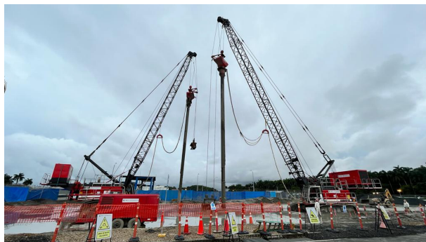
Ilustración 4: CIC construidas bajo tanques y compresores construidos para tratar suelos originalmente licuables. Las CIC fueron construidas con equipos que cuentan con barrenas de perforación tipo desplazamiento lateral de suelos. Veracruz, México.
